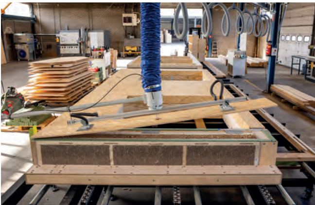
De hsb-elementen worden aan de binnenzijde voorzien van OSB-beplating.
