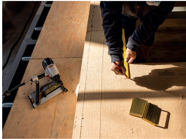
Aan de buitenzijde krijgen de elementen houtvezelplaten. Hier wordt direct op gestuukt.
